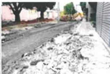
Corte e levantamento de pavimentos
