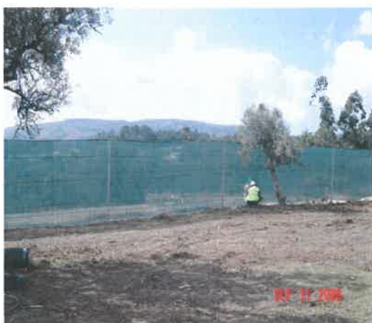
Fig. 1 – Execução de vedação do estaleiro
