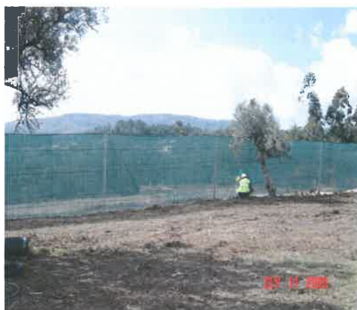
Fig. 1 – Execução de vedação do estaleiro
